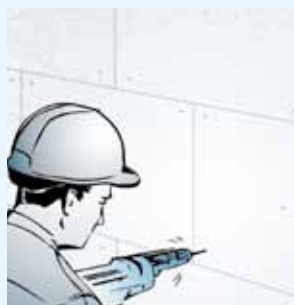
Fig. 8 : Fixation des chevilles
